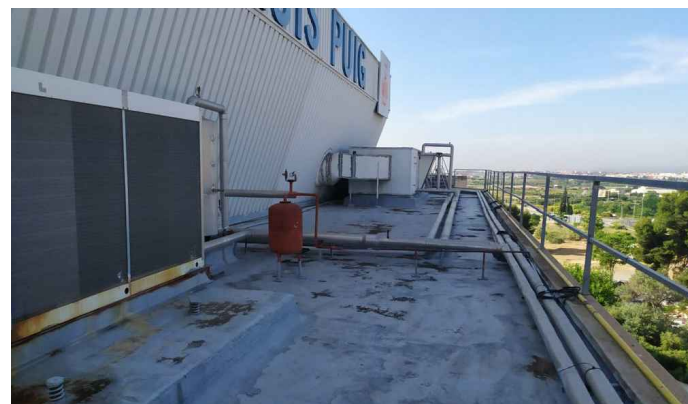
FOTO 3 - VISTA GENERAL DE LA CUBIERTA BLOQUE 2.
