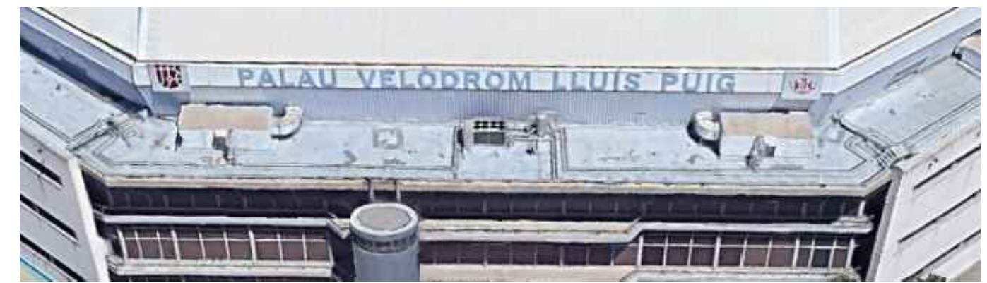
VISTA AÉREA CUBIERTA BLOQUE 2
