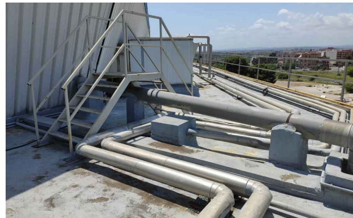
FOTO 1 - VISTA GENERAL DE LA CUBIERTA BLOQUE 2.
