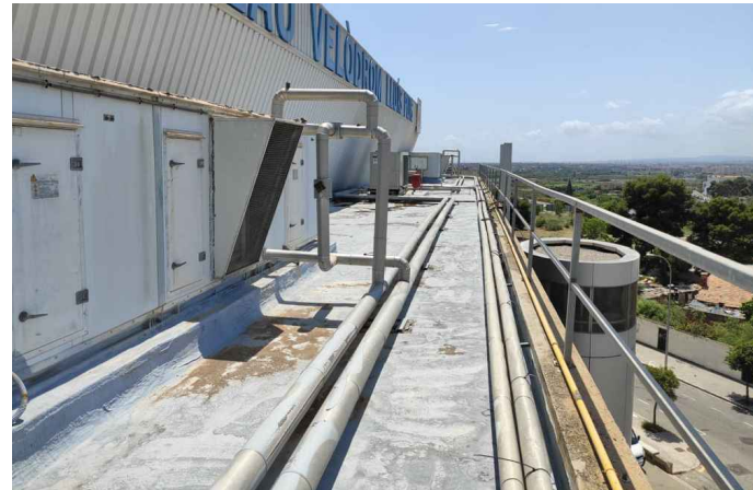
FOTO 2 - VISTA GENERAL DE LA CUBIERTA BLOQUE 2.
