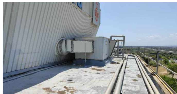
FOTO 4 - VISTA GENERAL DE LA CUBIERTA BLOQUE 2.
